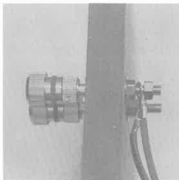
《写真F》端子は裏板に直接止める
